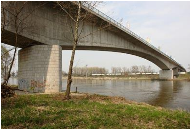
Fig. 1: Bridge in Mělník.
